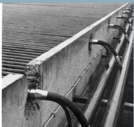
Speciale rubberen HD-slangen (Eriks) met pakkingloze, conische koppelingen verbonden de 269 pijpsegmenten (11 bij 1,8 meter) met de dikke ringleidingen.
